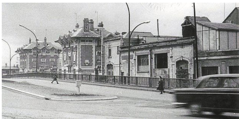
Les abattoirs, vue vers les pavillons d'entrée, qui faisaient face à la Maine, mars 1965.
