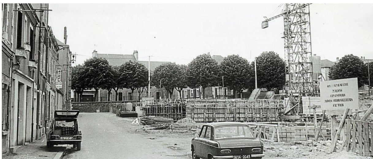
Un secteur en chantier en juin 1973.
