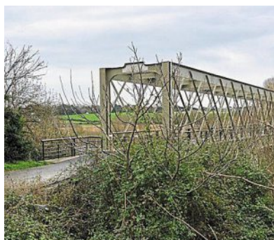
Le pont a été sauvé de la démolition dans les années 70. PHOTO : CO - LAURENT COMBET
