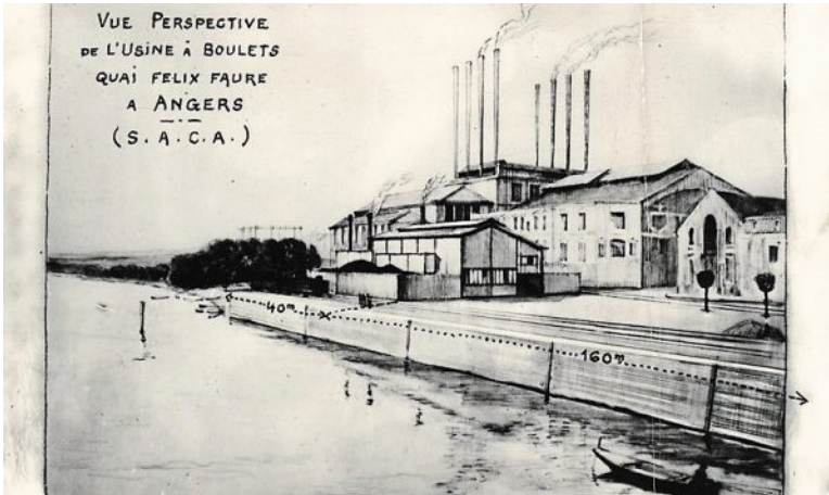
Projet d’usine à boulets à Angers, 1936. PHOTO : ARCHIVES PATRIMONIALES ANGERS, 5 FI 2142
