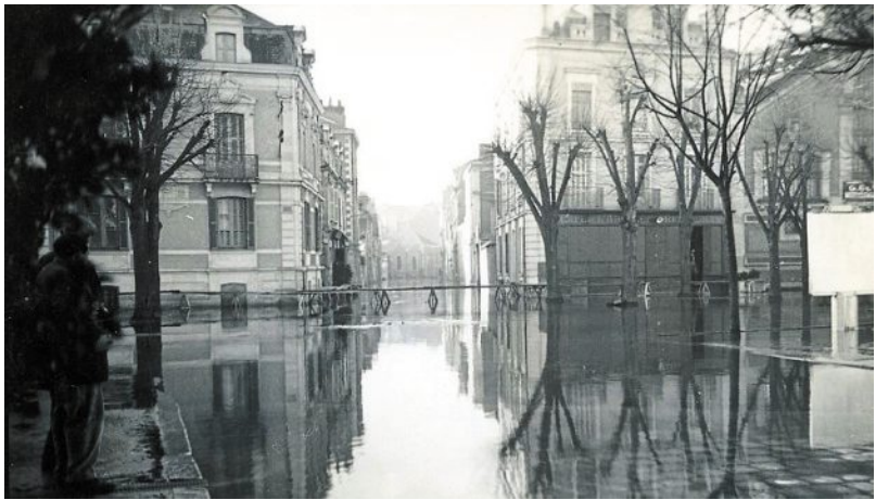
Perspective vers la rue Maillé, carrefour boulevard Ayrault, lors des inondations de 1936.
