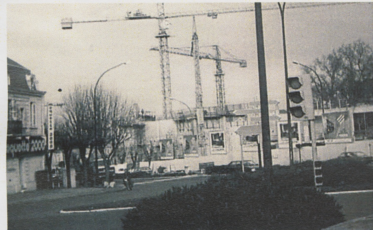
Le Centre de congrès en construction, 26 novembre 1981. Archives municipales,
